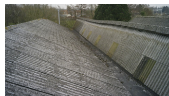
De karakteristiske shedtage var oprindeligt beklædt med tagpap.
